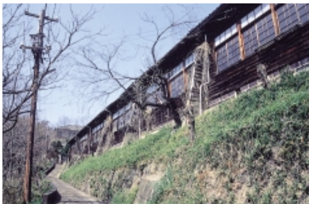
写真147 小学校校舎(南から望む)
