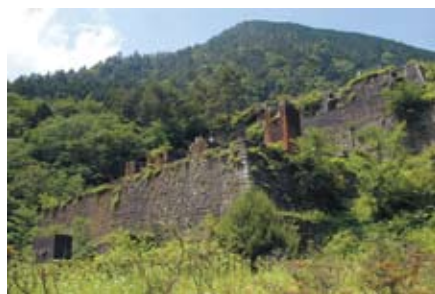
東平の貯鉱庫・索道基地跡
