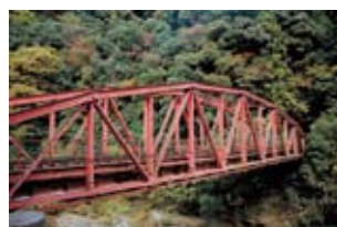
旧別子鉱山鉄道 端出場鉄橋及び端出場隧道
