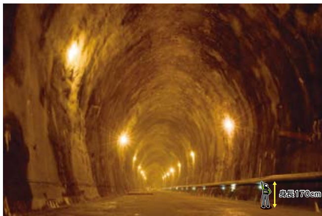
岩盤を掘った貯槽 高さ30m・幅26m・長さ485m
