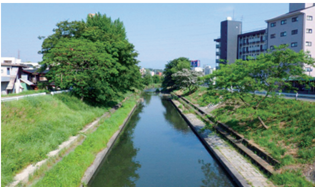
写真3 上吉木橋よりのぞむ小野川（旧吉木川）
