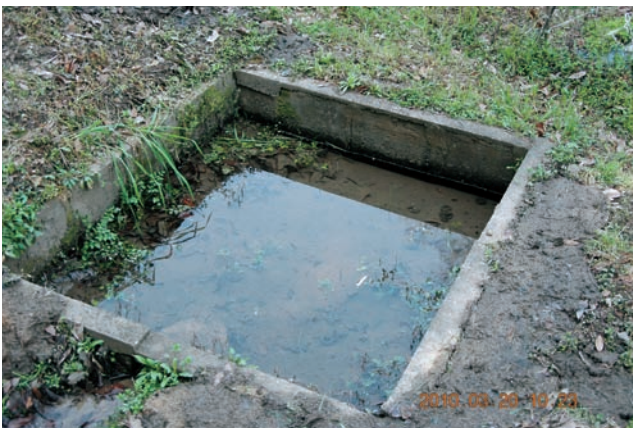
写真9 産地5の農業用貯水槽 コンクリート製で手前側の面に流出孔がある。
