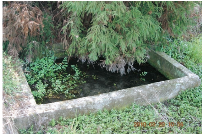
写真11 産地6の産卵場所 コンクリート製の貯水槽が利用されている。
