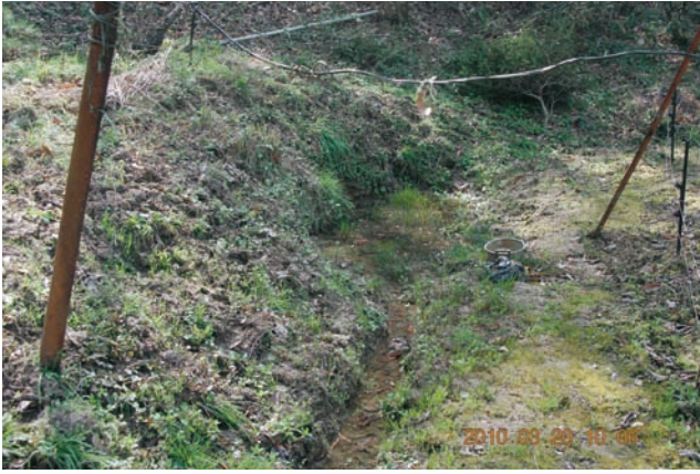
写真7 産地4の小水路 農地に沿って一部が掘り下げられている。
