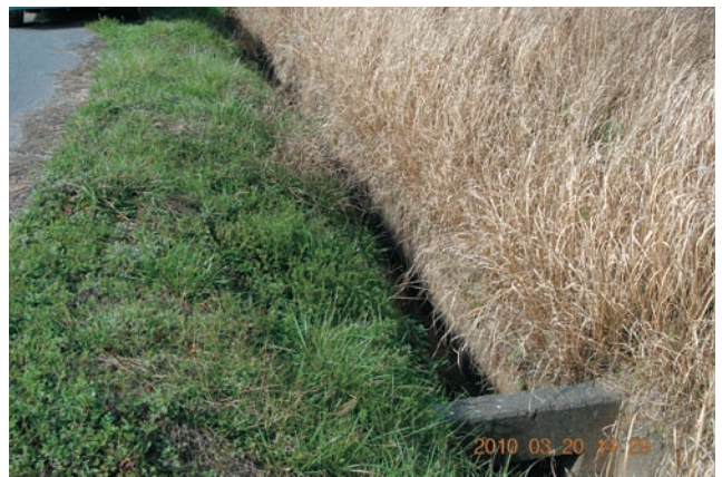
写真24 産地13の概観 農道脇のコンクリート三面張水路。
