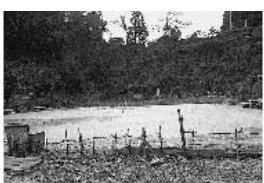
写真8 現在の旧窓の峠トンネル吉野側（平成10年2月2日撮影）
