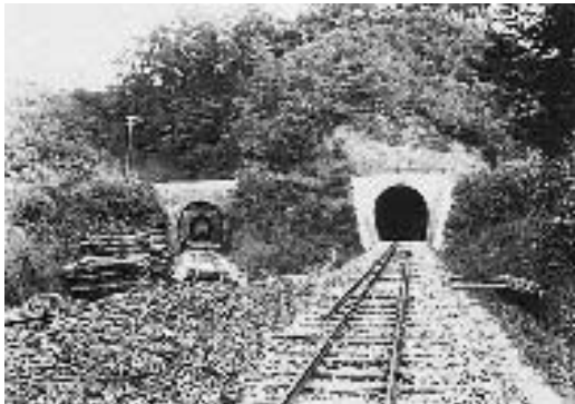
写真3 改軌工事中の窓の峠トンネル宇和島側。右側が現在使用している窓の峠トンネルである。左側手前は、道路の下を通るトンネルで奥が旧窓の峠トンネルである。（写真提供兵頭林一氏）
