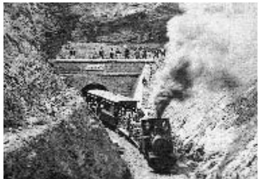
写真6 開業直前の旧窓の峠トンネル吉野側（写真提供弓滝神社）
