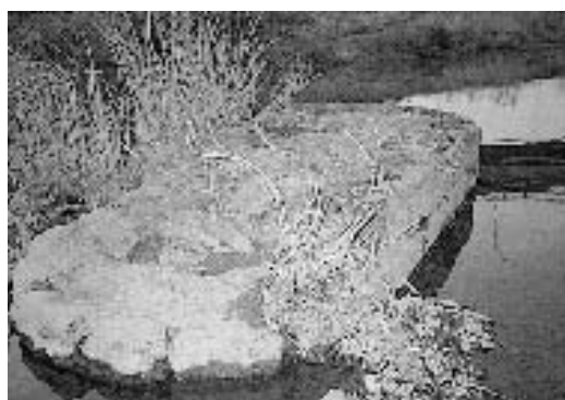
写真19 旧五郎鉄橋橋脚跡（平成10年2月9日撮影）
