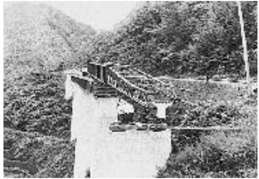
写真2 建設中の椿谷橋梁（写真提供兵頭林一氏）
