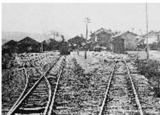
写真18 愛媛鉄道営業時の旧大洲駅（「愛媛鉄道国鉄移管記念写真帖」より）
