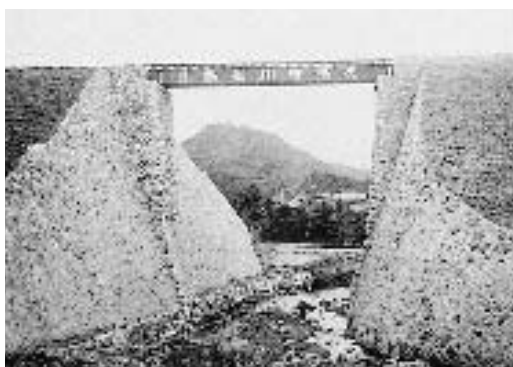
写真10 建設直後の久保田川橋梁（写真提供上田恵美子氏 「宇和島鉄道株式会社 近永吉野生間延長線工事記念写真帖」より）
