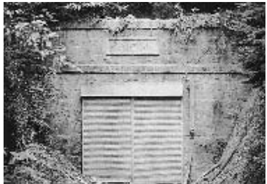
写真4 昭和47年の旧窓の峠トンネル宇和島側（昭和47年8月20日撮影）
