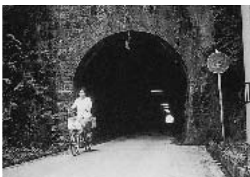
写真20 拡幅前の旧和田トンネル長浜側（昭和60年8月23日撮影）
