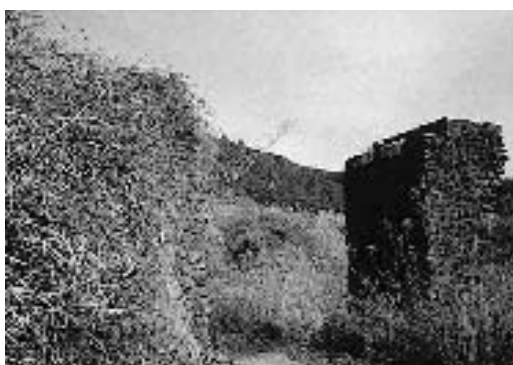
写真12 吉野松丸間の橋台（平成10年1月22日撮影）
