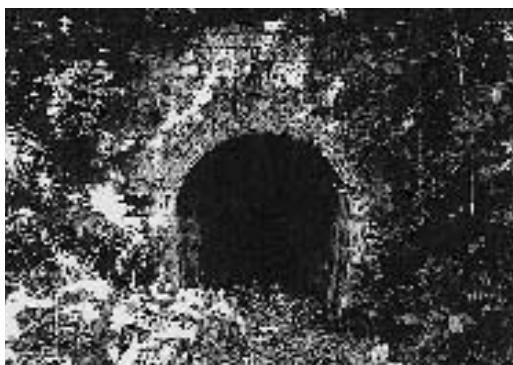
写真24 旧河内トンネル長浜側（平成9年7月18日撮影）
