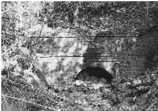
写真5 現在の旧窓の峠トンネル宇和島側（平成10年2月2日撮影）
