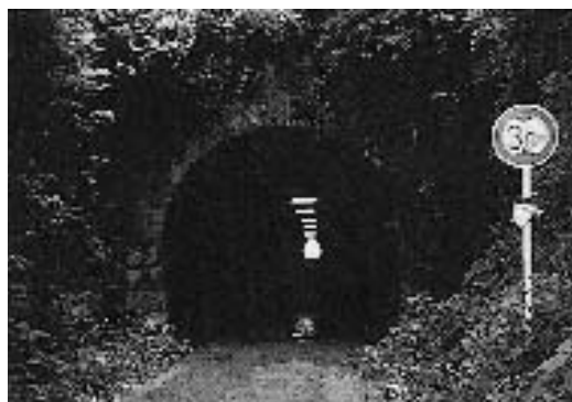
写真23 旧八多喜トンネル長浜側（平成9年7月18日撮影）
